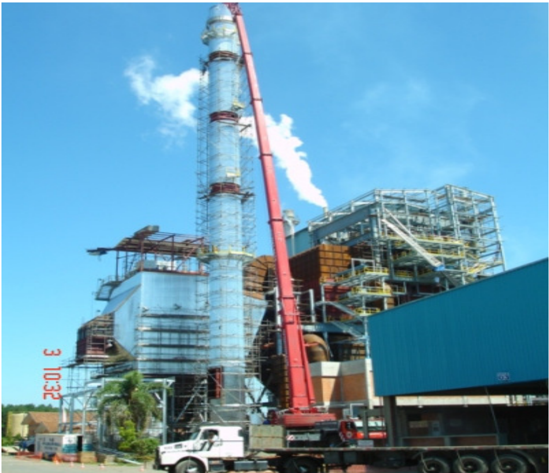
Figura 36: Caldeira de Leito Fluidizado. (Fonte: SERMATEC, Caldeiras de Leito Fluidizado, 2003)
